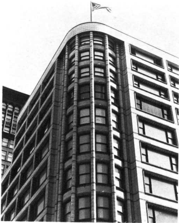
Fig. 65. Edificio CPS: detalle de la torre esquinera
