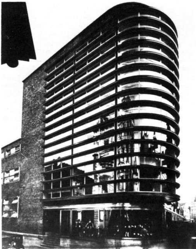
Fig. 71. Grandes Almacenes Schocken, Stuttgart: torre de escalera y fachada Sur
