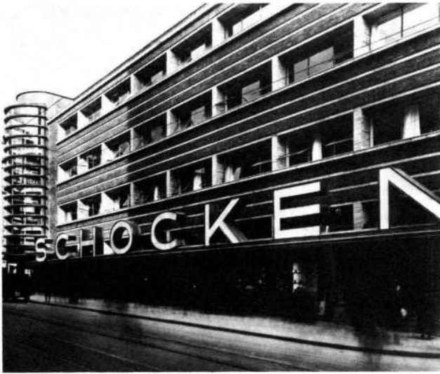
Fig. 73. Grandes Almacenes Schocken, Stuttgart: vista desde el Noreste
