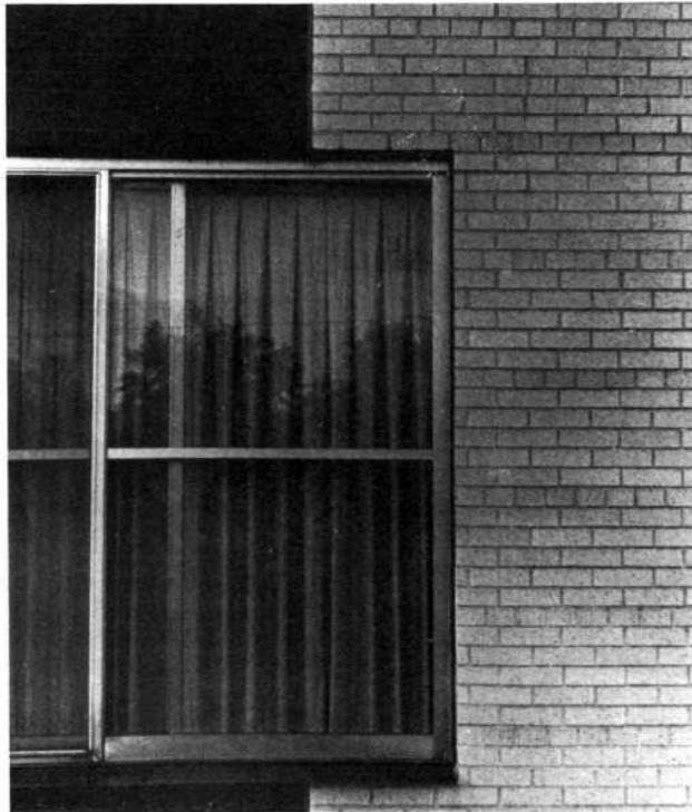
Fig. 29. Cuartel de Bomberos N.º 4: detalle
